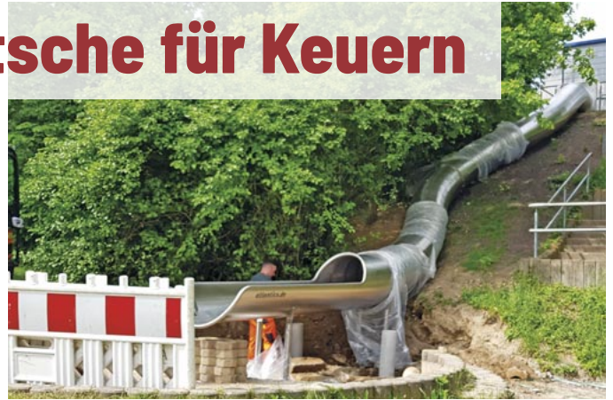
Mitarbeiter des Bauhofes richteten den Fallschutz an der neuen Rutsche in Keuern her. Die Röhrenrutsche selbst wurde in Döbeln gebaut. Foto: Maria Fricke
