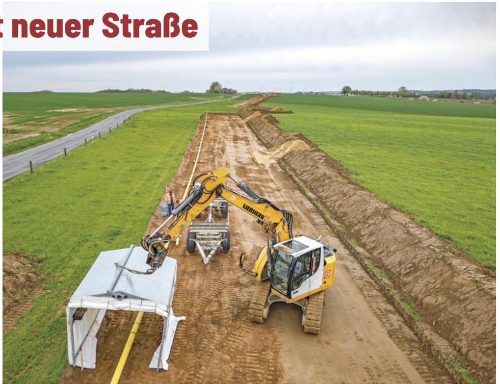
Auf einer Länge von knapp 1,2 Kilometern lassen die Stadtwerke Döbeln derzeit entlang der S 32 zwischen Neudorf und Döbeln eine neue Gashochdruckleitung verlegen. Die bisherige Leitung liegt im Baufeld der neuen Straße. Foto: LKW
