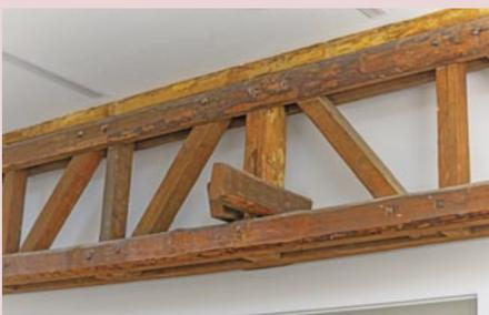
Im Dachgeschoss der ehemaligen Kaserne sind die Balken ausgebessert und dauerhaft freigelegt worden.
