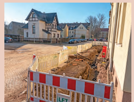
Auf einem rund 100 Meter langen Abschnitt am Gehweg an der Zuckerfabrikstraße werden erst Leitungen neu verlegt, dann der Gehweg neu gestaltet. Foto: L. Weidler
